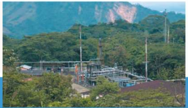
Infraestructura que compone el campo de gas Gibraltar. / Sebastián Cote
